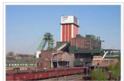
Schachtanlage "Friedrich Heinrich 1/2" in Kamp-Lintfort.
