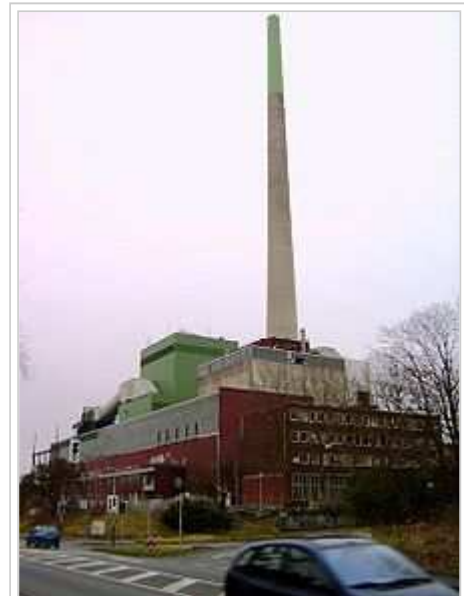
Das ehem. Kraftwerk Rauxel während der Abbrucharbeiten
