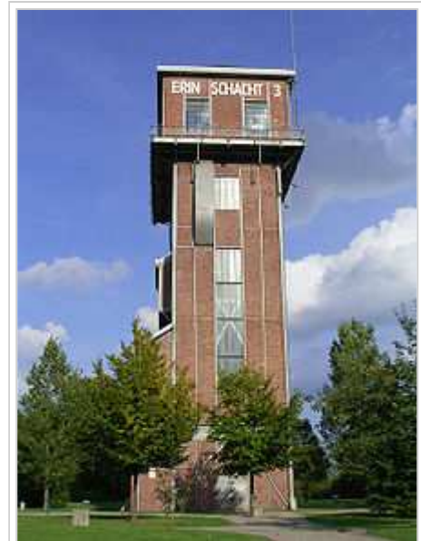
Hammerkopfturm Erin Schacht 3
