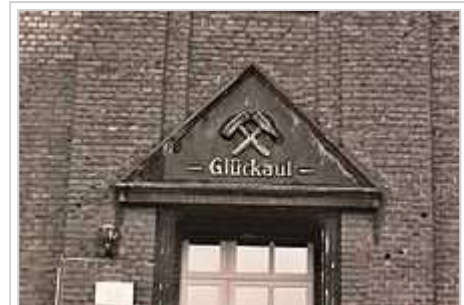
Bergmannsgruß Glückauf mit Schlägel und Eisen über dem Eingang zu einem ehemaligem Zechengebäude im südlichen Ruhrgebiet
