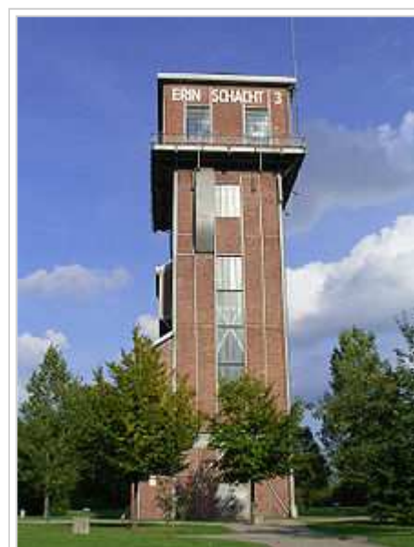
Hammerkopfturm über dem Wetterschacht 3 im Stadtteil Schwerin
