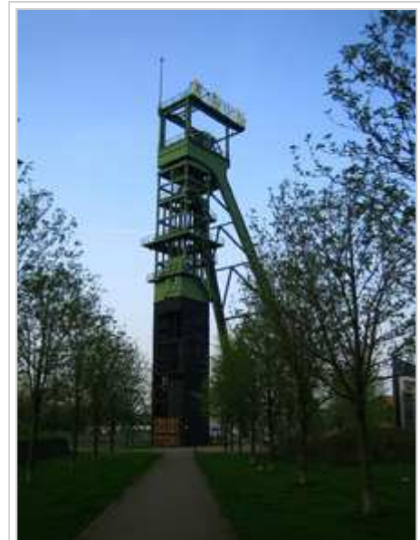
Fördergerüst über Schacht 7 der Zeche Erin im Stadtteil Castrop (2005)
